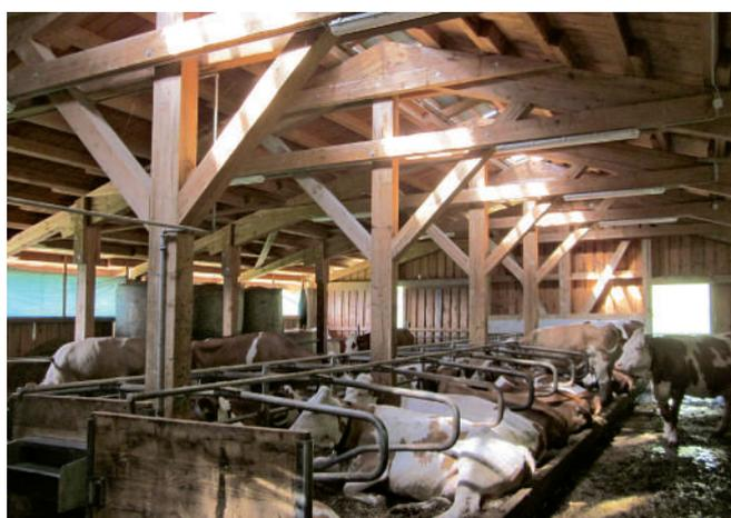
Abbildung 21: Liegeboxenlaufstall mit Tiefboxen, Bundwerk mit Koppelpfetten
