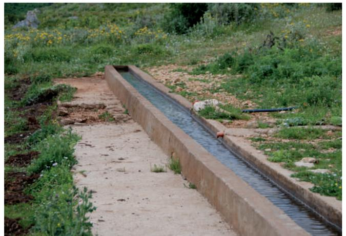
Abbildung 65: Betonierter Tränketrog – der Vorplatz des Tränkeplatzes ist betoniert, um Morastbildung zu vermeiden. (© Stefan Hellebart)
