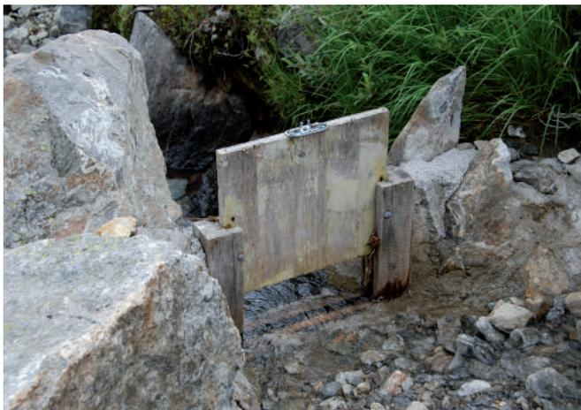
Abbildung 73: Ein Einlauf zu einem Zuleitungsgraben (© Stefan Hellebart)
