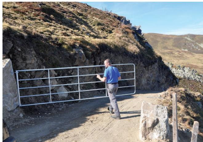
Abbildung 111: Breitenverstellbares Alu-Drehtor (© Norbert Kerschbaumer)
