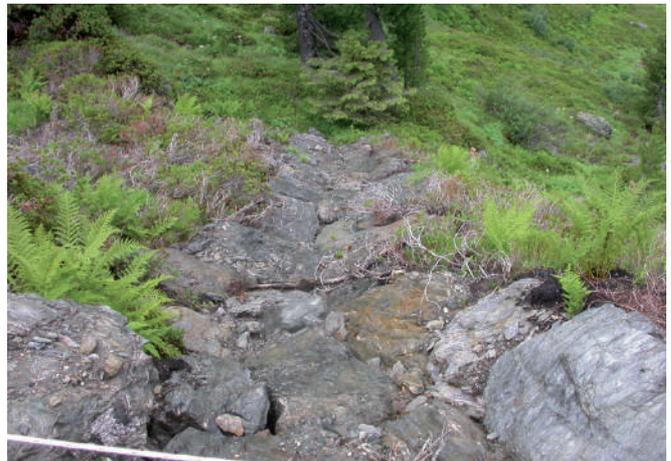
Abbildung 85: Das Niederschlagswasser von Weg- und Hofflächen wird durch eine Raubettgerinne geleitet – dadurch sollen Erosionen an der talseitigen Böschung vermieden werden; das Niederschlagswasser wird, im Gelände verteilt, zur Versickerung gebracht. (© Stefan Hellebart)
