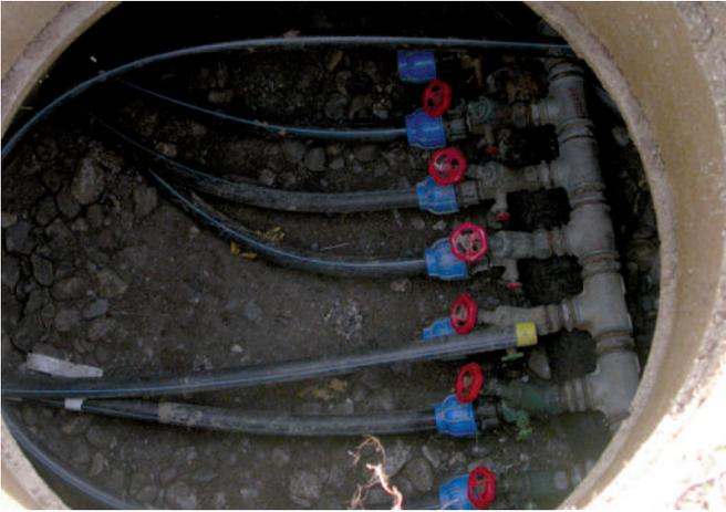
Abbildung 59: Ein offener Verteilerschacht – die einzelnen Wasserleitungen führen zu den Almhütten; in den Wintermonaten können die Wasserleitungen entleert werden. (© Stefan Hellebart)
