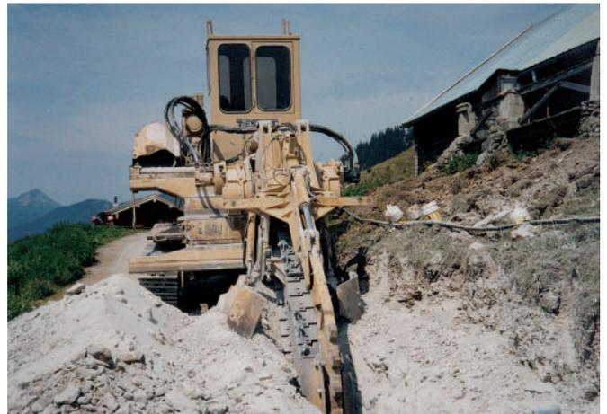
Abbildung 45: Fräsmaschine zur Verkabelung einer Stromleitung (© Kurt Egger)
